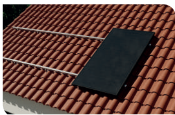
Étape 3 Pose panneau et micro-onduleur
